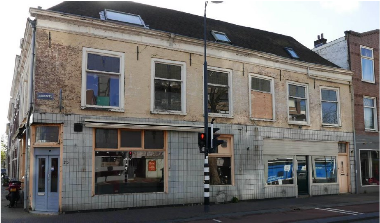
Afb. 3 Foto van de westgevel (Enderman 2018)
